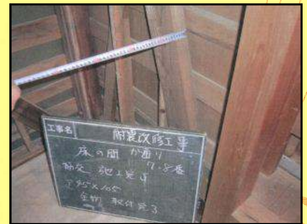
耐震改修工事
