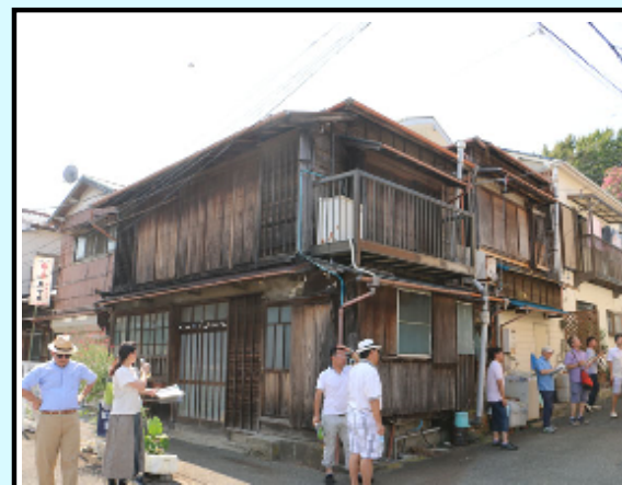
空き家視察調査の様子
