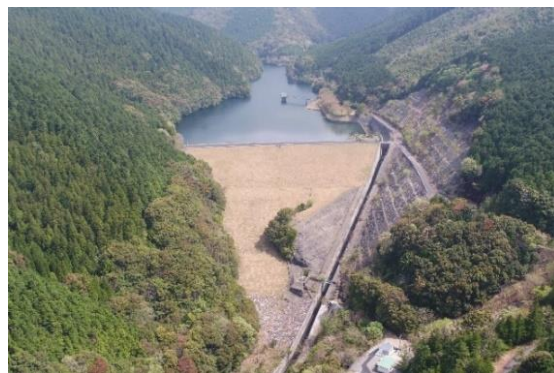
大久保山ダム(愛南町)
