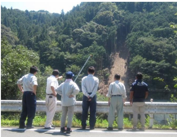
国道 197 号 (肱川流域) (大洲市肱川町)
