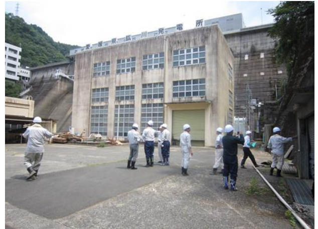
肱川発電所 (大洲市肱川町)
