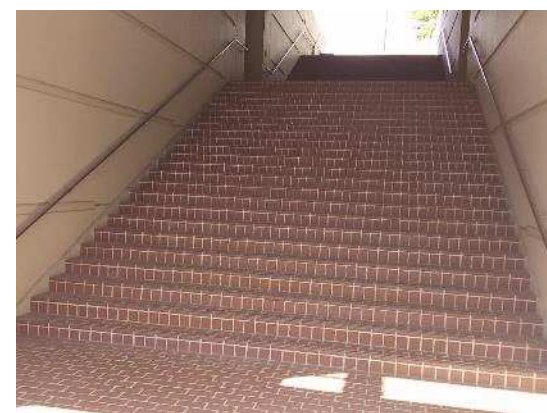
階段や手すり
