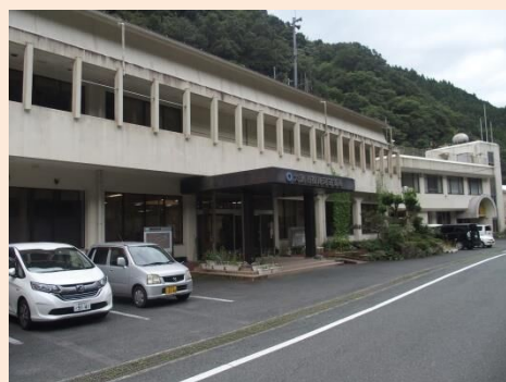
大洲市河辺支所
