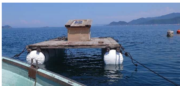
写真4 水質テレメータ設置状況（下灘）
