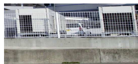
(電気設備の移設)
