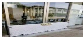
(止水板の設置)
