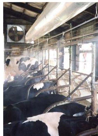
図8-3 ダクト細霧法の概要(出典:愛媛県畜産試験場、気候変動適応情報プラットフォーム(A-PLAT))
