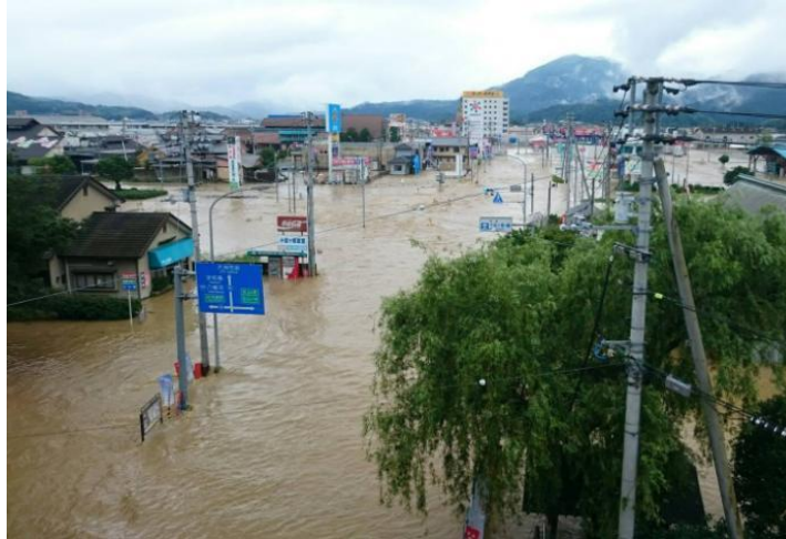
図 6-8 冠水する大洲市内を通る国道 56 号 (平成 30 年 7 月豪雨時) (出典: 国土交通省)
