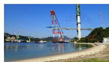
建設現場の状況
