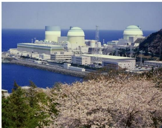
【四国電力㈱伊方発電所（全景）】
