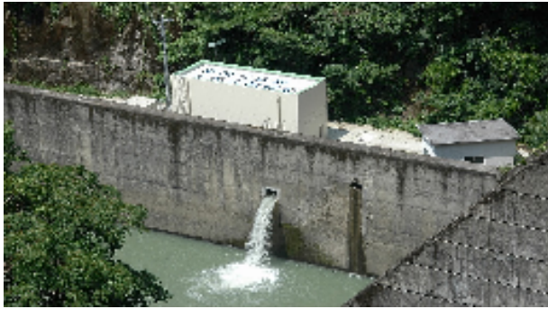
有田川町営二川小水力発電所
