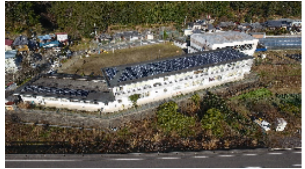
旧峯口小学校太陽光発電所
