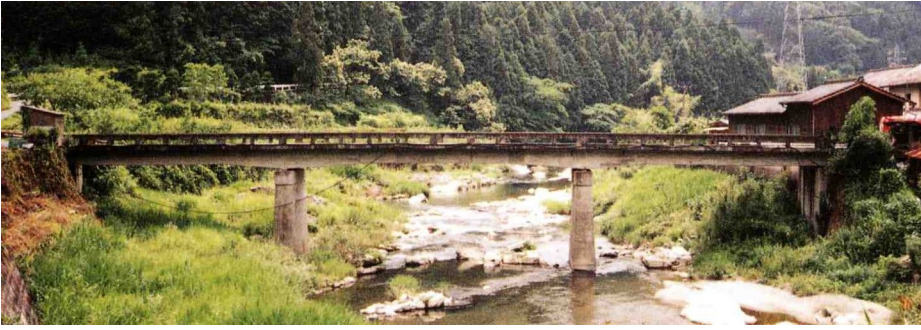
町道 今岡線 今岡橋 鉄筋コンクリートT型 L = 42.0\text{m} W = 4.0\text{m} 昭和 37 年 一般林道で架設 内子町
