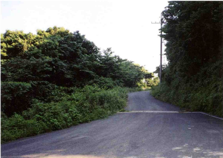
町道 松・伽藍山線 昭和 47 年～昭和 49 年 普通林道伽藍山線で開設 伊方町（旧三崎町）
