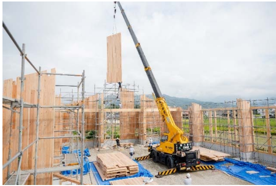
CLT建築物の建設支援
