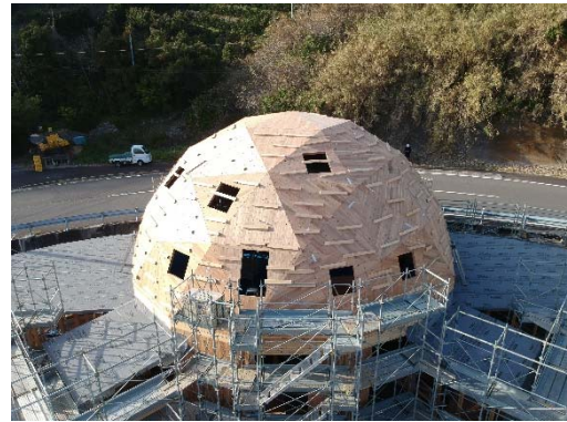
CLT建築物の建設支援
