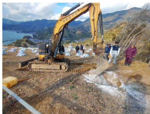
重機による土壌改良資材の土壌混和作業
