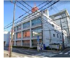
①NTT愛媛ビル2棟
