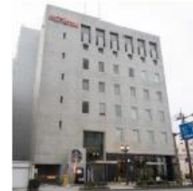
④伊予鉄本社ビル
