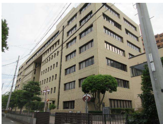
(庁舎外観北面)
