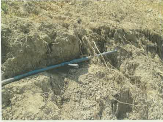
散水線(スプリンクラー)の復旧
