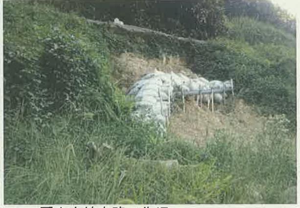
園内支線水路の復旧
