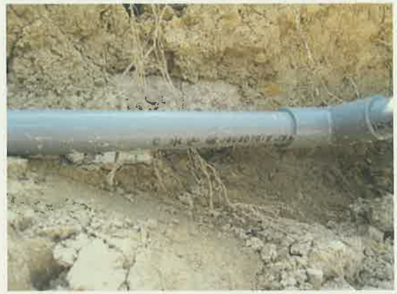
散水線(スプリンクラー)の復旧
