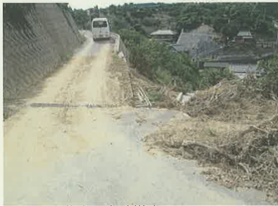
道路の土砂撤去
