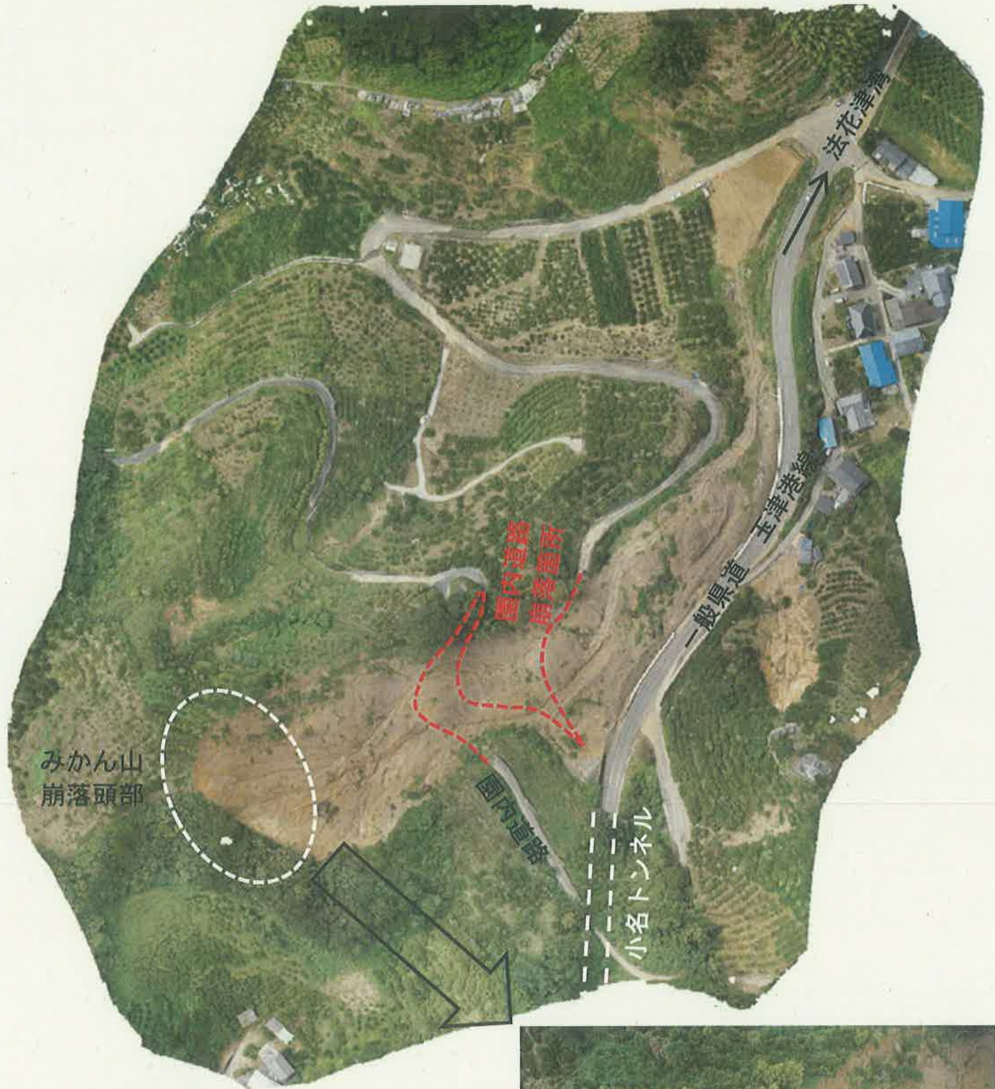
ドローンによる空中写真【白浦工区】（H30. 9. 23）
