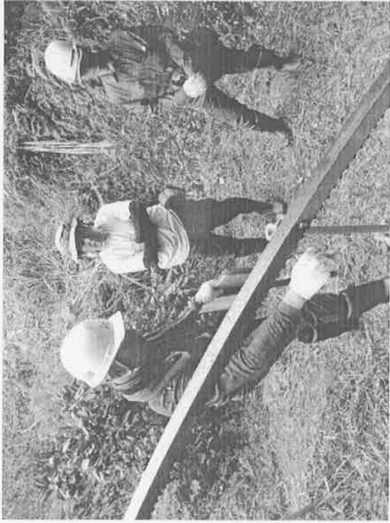
図1 支柱の取り付け位置の確認
