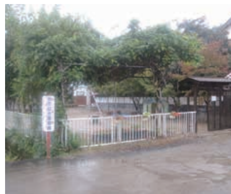
<施設外観(正面入口)>
