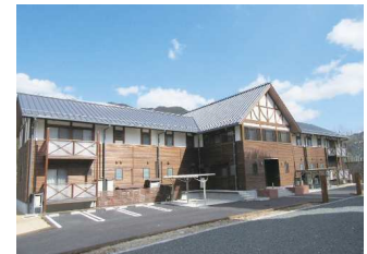
木造施設整備(上浮穴高等学校学生寮)
