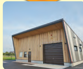
木造公共施設の整備
