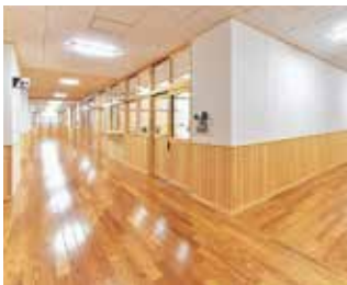
内装の木質化
