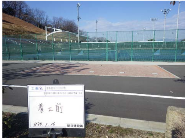
施行箇所（施行前）
