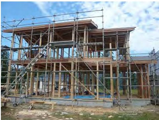
展示住宅建設中
