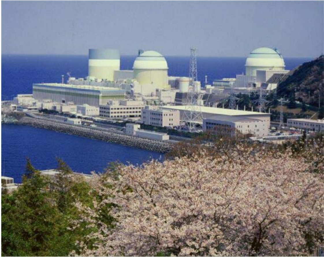
四国電力株式会社伊方発電所（全景）
