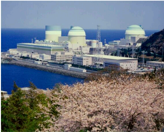
図2-1-9 四国電力㈱伊方発電所（全景）
