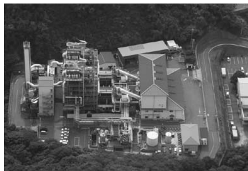
愛媛県廃棄物処理センター
