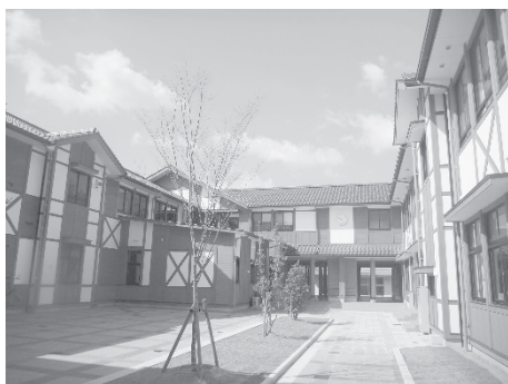
公共施設木材利用推進事業 (公共施設の木造化)
