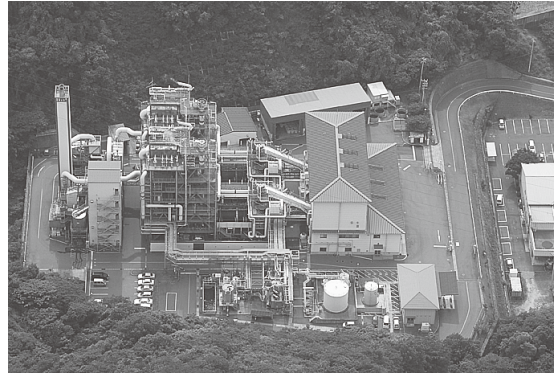
愛媛県廃棄物処理センター
