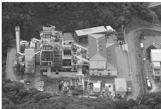
愛媛県廃棄物処理センター
