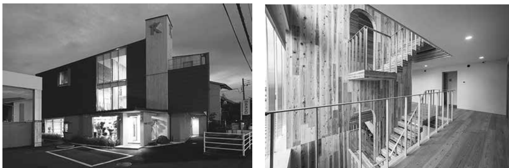
【愛媛県内初の CLT を利用した事務所(松山市)】
