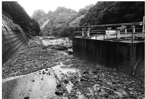
吉田浄水場の被害状況
