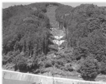
【山地災害跡地への 治山施設整備】
