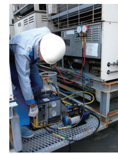
スーパーマーケット冷蔵ショーケース(室外機)からのフロン類冷媒回収の様子 写真提供：冷媒回収推進・技術センター
