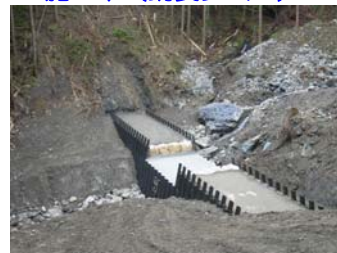
施工中（鋼製ダム工）
