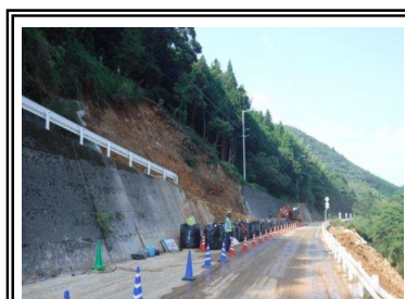
H30/7/14 崩土撤去完了
