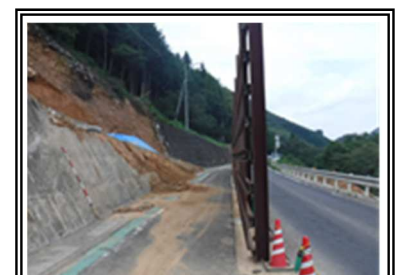
仮設防護柵設置
