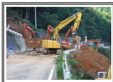
H30/7/8 応急施工状況
