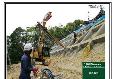
鉄筋挿入工施工状況
