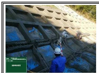
法枠施工状況
