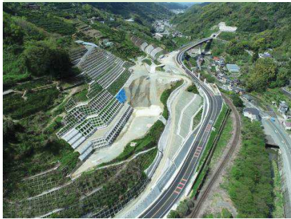
【大洲・八幡浜自動車道整備】
