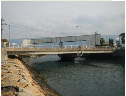
【港湾施設耐震補強対策】
