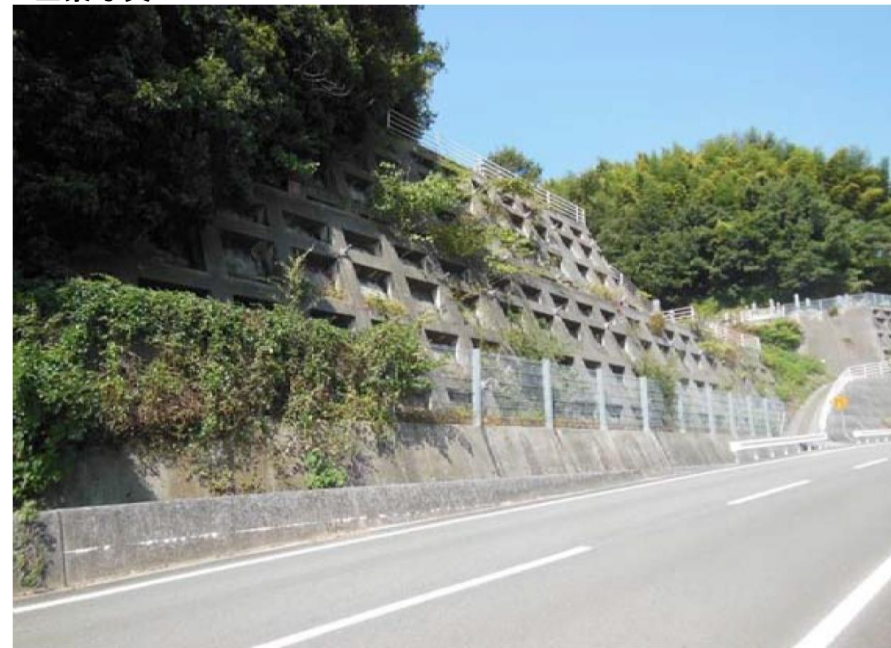
対象施設全景(起点側)
