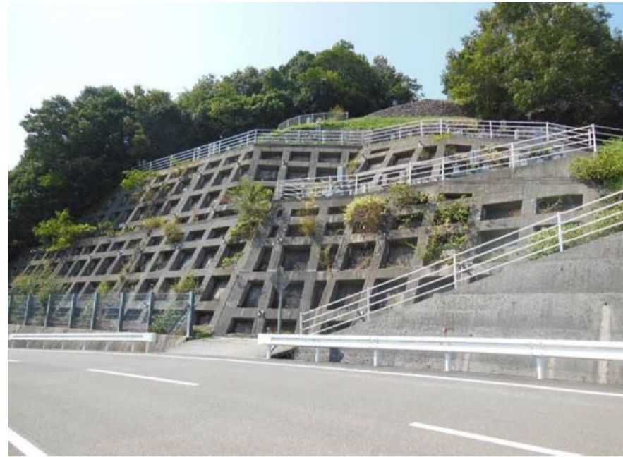
対象施設全景(終点側)
