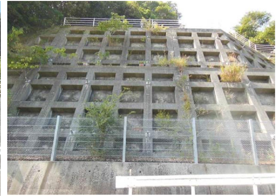
対象施設全景(正面)
