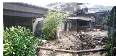
高浜5丁目の住宅被災状況
