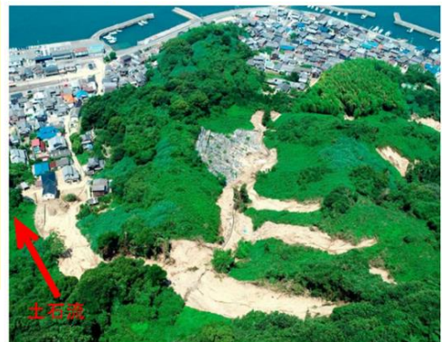
小型無人機で撮影した高浜地区の土砂崩れ現場(高浜地区自主防災委員会提供)
