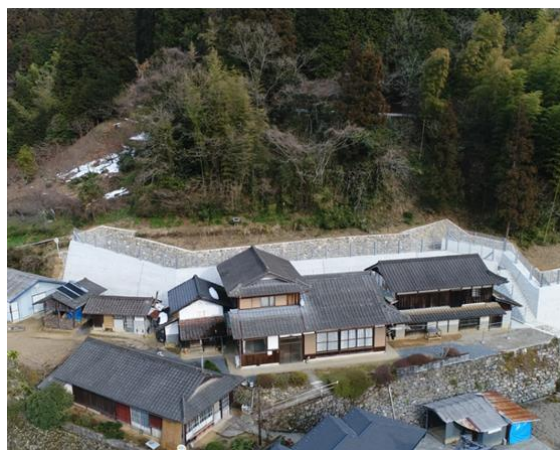
写真一 4.2 急傾斜地崩壊対策施設の事例
