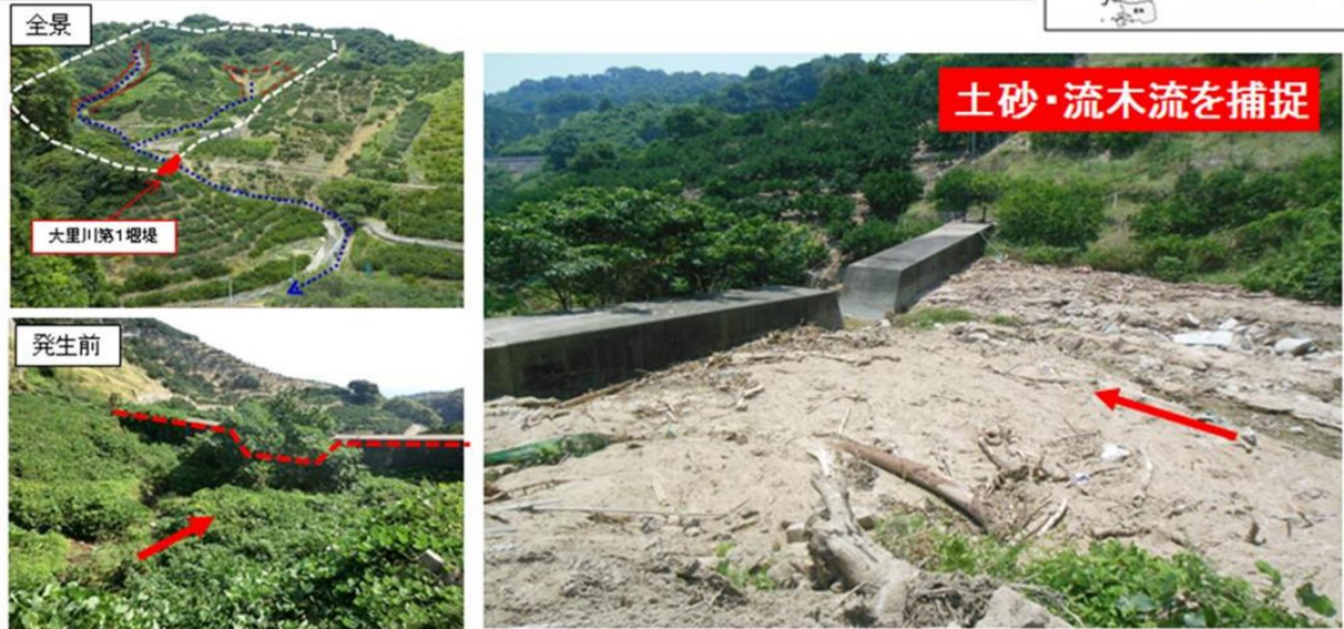
図-4.8 砂防えん堤が土砂を捕捉した事例（松山市）
