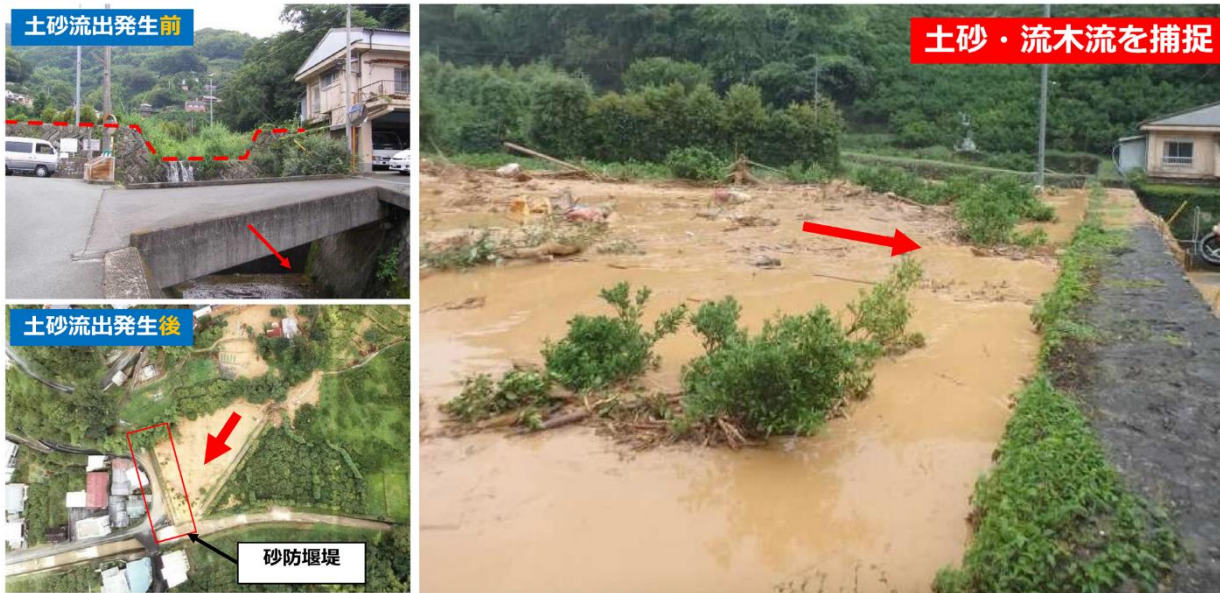
図-4.7 砂防えん堤が土砂を捕捉した事例（八幡浜市）
