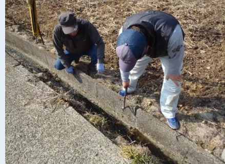
水路の点検作業
