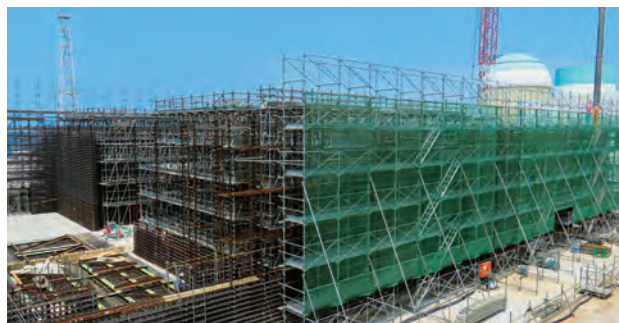
現在、建物の基礎部分や壁面を構築する工事を実施
