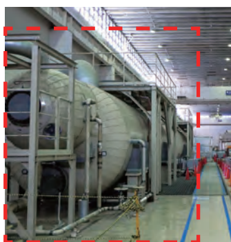
熱交換器など2次系設備を解体・撤去
