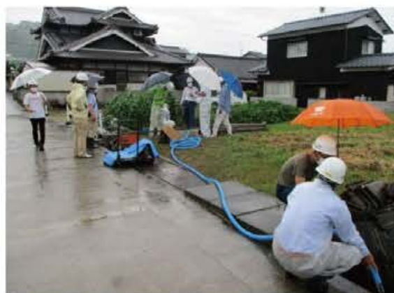
汚水排水訓練
