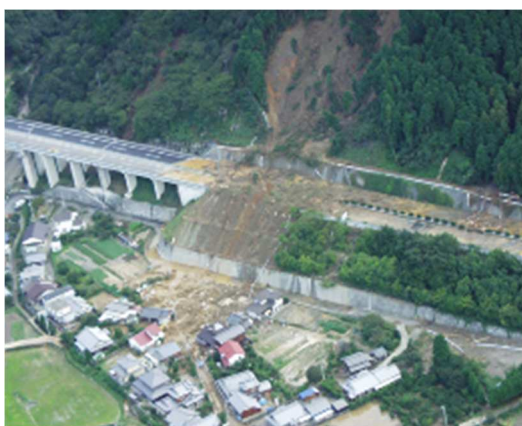
H16 台風第21号 がけ崩れ（新居浜市）
