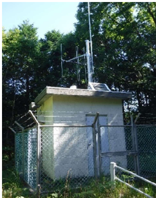
ふ あめ かんそく せつび 降った雨を観測する設備 で、2か所あります。
