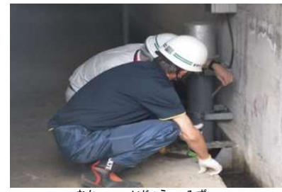
ダムの中から異常な水がもれてい ないか調査します。
